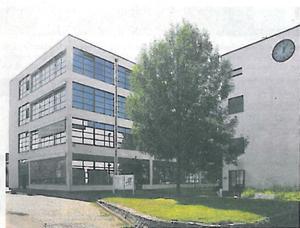
Makelloser Bauhausstil : das HE-Gebäude mit Uhrenturm; daran schließen sich die Shed-Hallen an. RP-ARCHIV: BKÖ
