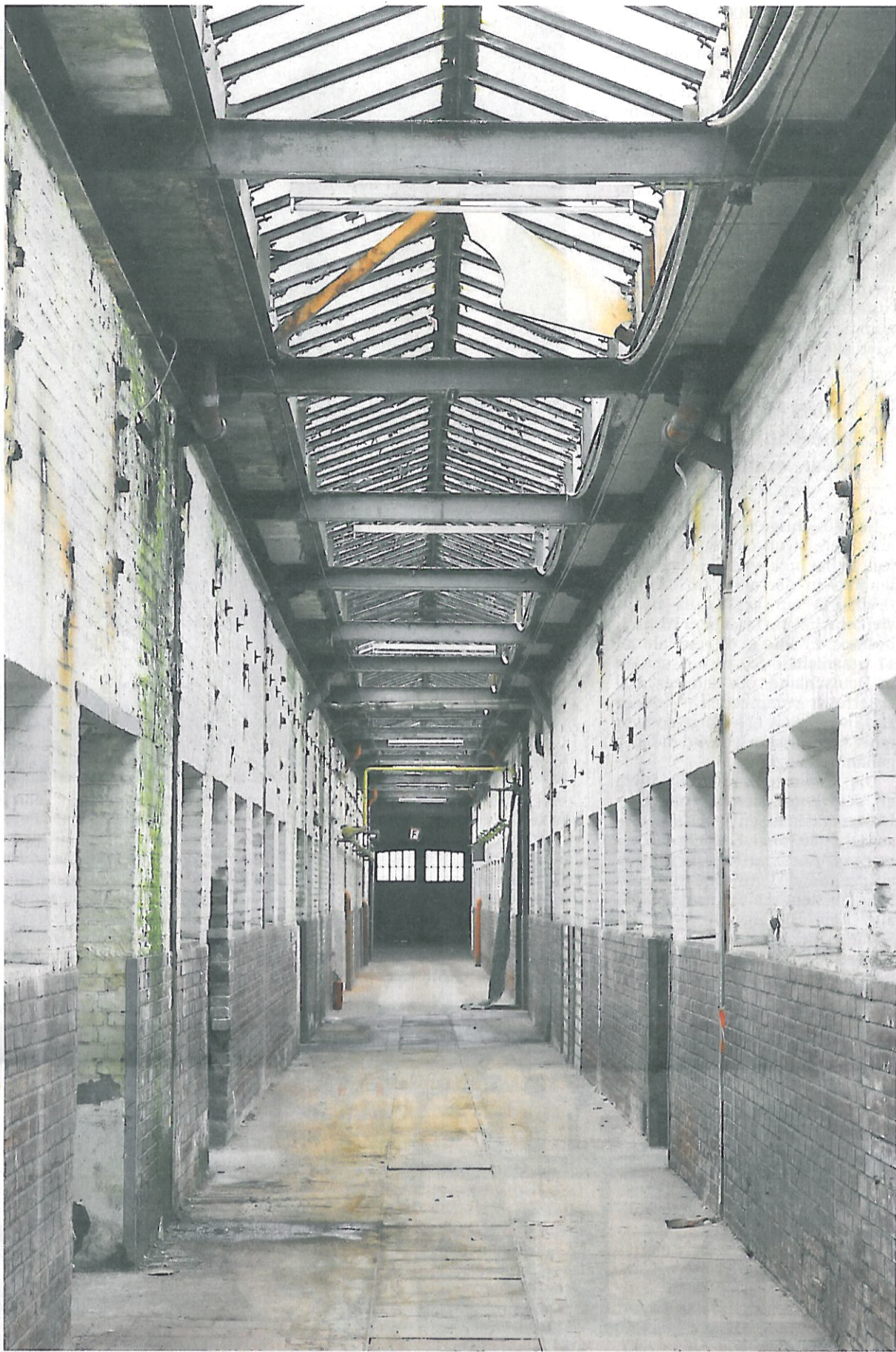
Blick in einen Gang in den Shed-Hallen : Architekturfreunde schätzen an Mies van der Rohes Stil die reduzierte Formensprache und die klare Funktionalität. RP-FOTO: LOTHAR STRÜCKEN
