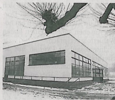
Die Alte Schlichterei: Allein die Fenstersanierung hat 200 000 Euro gekostet.
