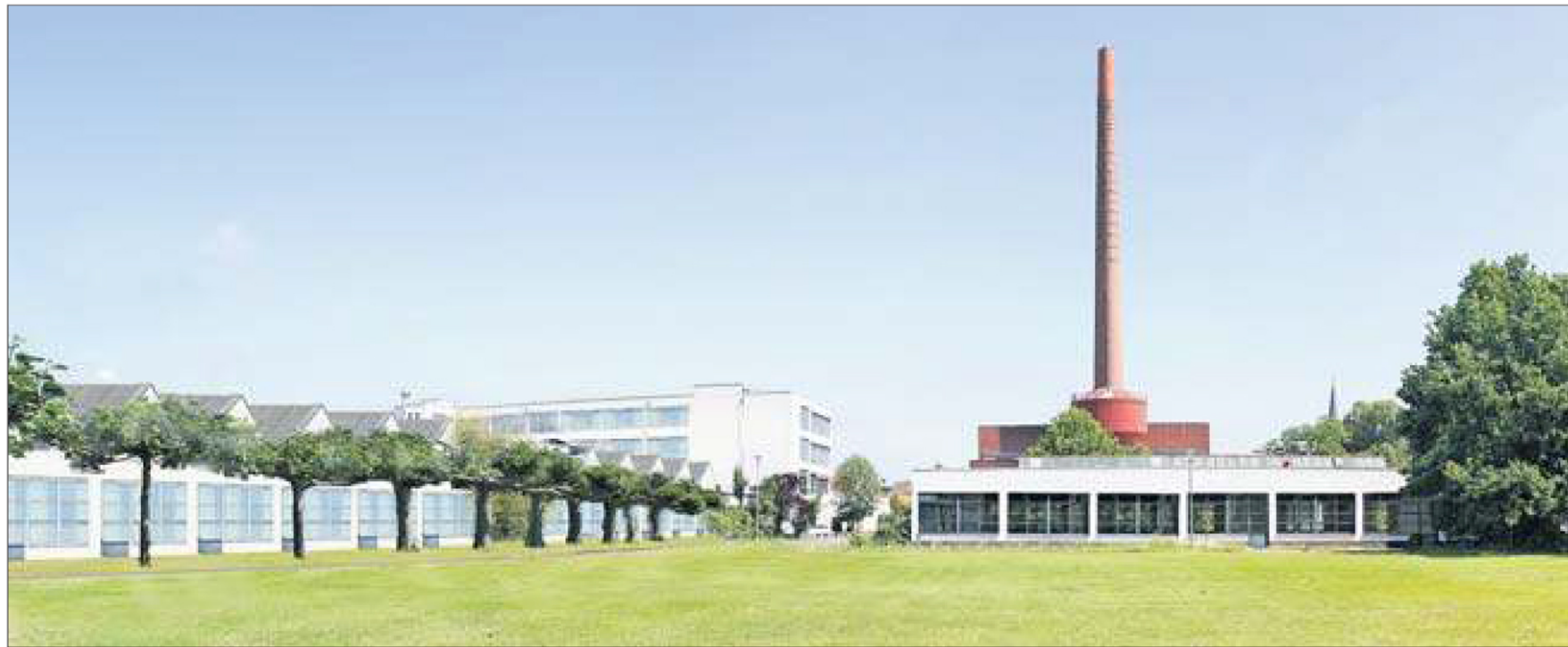
So soll der Mies van der Rohe-Businesspark einmal aussehen: Die Shedhallen links erhalten nach der Sanierung einen weißen Anstrich. Eine Baumallee erstreckt sich entlang der Hallenfassaden. Rechts ist die alte Schlichterei zu sehen. Im Hintergrund das Kesselhaus. Foto: privat
