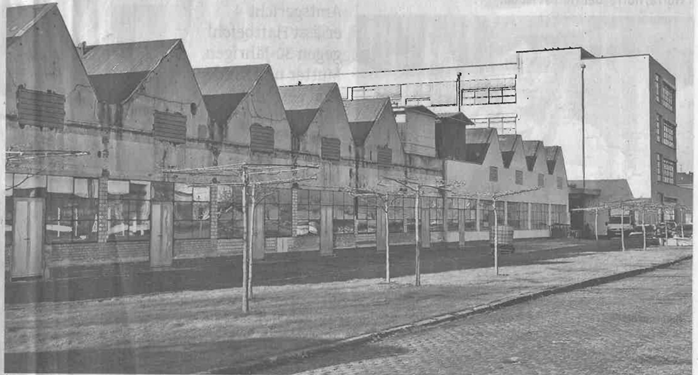
Die Shed-Hallen im Mies-van-der-Rohe Business-Park an der Girmesgath.
